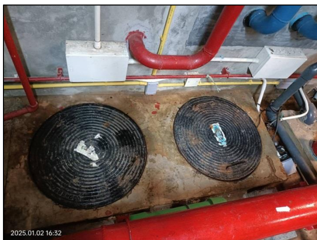
รูปที่ 3-8 บ่อเก็บน้ำ/ฝาบ่อเก็บน้ำใต้ดิน จำนวน 2 ฝา
