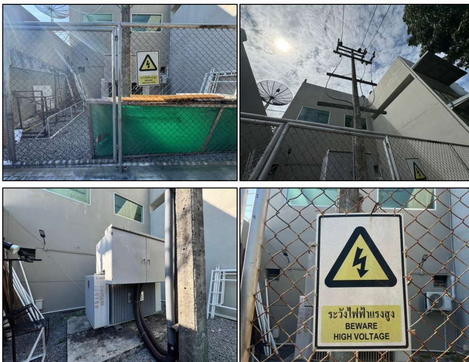
รูปที่ 3-19 หม้อแปลงไฟฟ้าแยกเฉพาะ และ ป้ายและคำเตือนอันตรายจากการถูกไฟฟ้าช็อต
