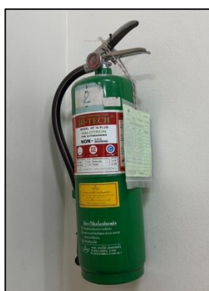
รูปที่ 3-41 ติดป้ายแนะนำการใช้ ถังดับเพลิงไว้บริเวณข้างถัง
