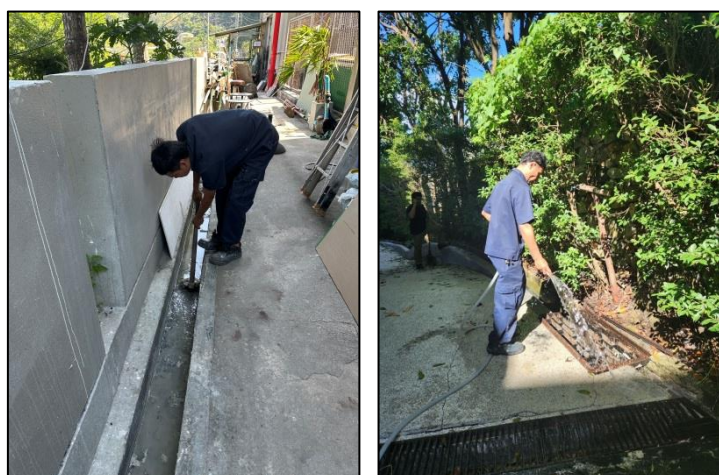
รูปที่ 3-63 เจ้าหน้าที่ทำความสะอาดท่อระบายน้ำ
