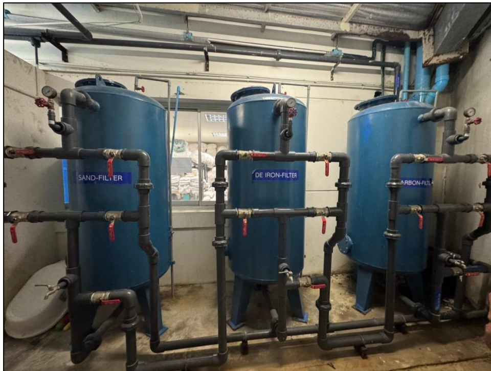
รูปที่ 3-67 รูปถ่ายระบบปรับปรุงคุณภาพน้ำของโครงการ
