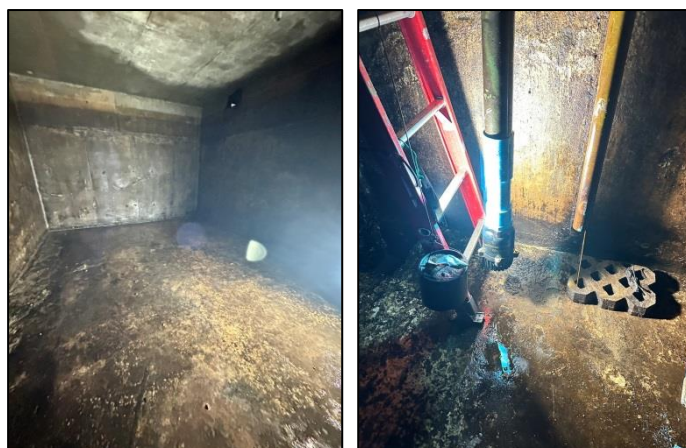
รูปที่ 3-10 ทำความสะอาด และตรวจสอบบ่อเก็บน้ำใต้ดิน
