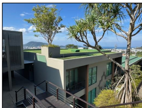
รูปที่ 3-21 วัสดุหญ้าเทียมบริเวณดาดฟ้า เพื่อลดความร้อนจากภายนอกเข้าสู่ภายในอาคาร
